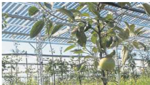
Solarmodule können nicht nur Sonne in Energie umwandeln, sondern – wie hier im Rahmen eines Forschungsprojekts des Fraunhofer-Instituts für Solare Energiesysteme ISE zusammen mit dem Ökoenergieanbieter Bay-Wa r.e. – auch vor zu starker Sonneneinstrahlung schützen. Herausgefunden werden soll bei dem Versuchsauflauf beispielsweise, wie sich das Lichtmanagement verschiedener Fotovoltaik-Modulkonfigurationen auf Wachstum und Erträge auswirkt.
