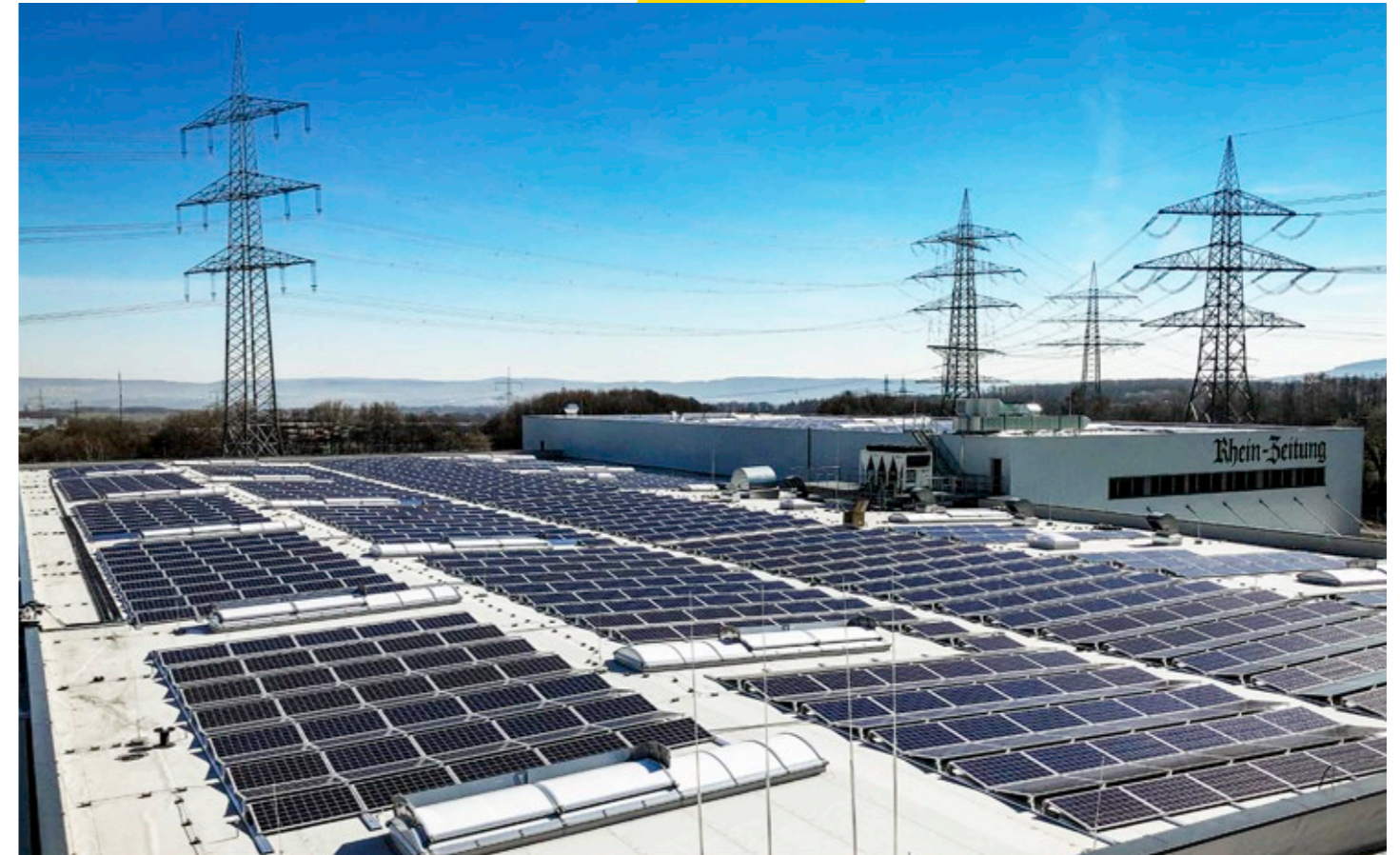
Maßgeschneiderte PV-Anlage von Wi SOLAR auf dem Dach des Druckhauses der Rhein-Zeitung.
