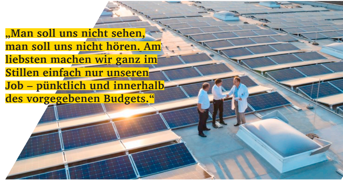
Das Wi SOLAR Energiekonzept auf der 10.000 m 2 großen Dachfläche der Weinkellerei ZGM in Zell an der Mosel.
