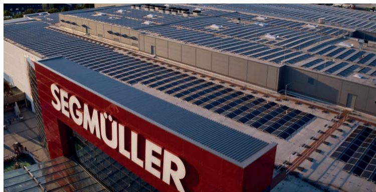
Wi SOLAR Photovoltaik-Anlage bei Segmüller Polstermöbelfabrik GmbH & Co. KG
