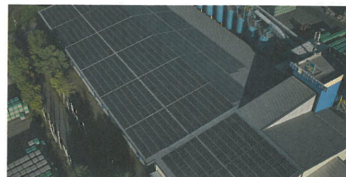
Die PV-Anlage auf einem Werksgebäude der Gebr. Zieglowski GmbH & Co. KG deckt im Energiemix 20 % des Gesamtenergiebedarfs ab.
