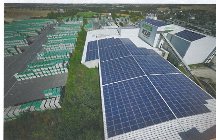
Das Werk Delfing betreibt seit 2015 eine PV-Anlage, die ...
